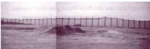
**Abb. 1: Kombiniertes Schrotfangsystem aus Fangnetzen und Oberflächenbefestigung**
