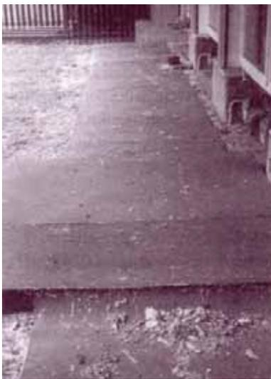
**Abdeckung der Schießbahnsohle mit Gummigranulatmatten**
